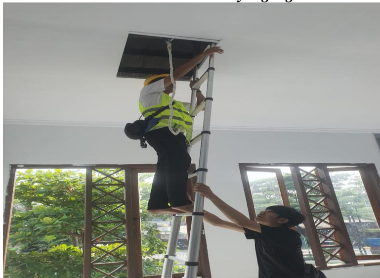
Gambar 3. 8 Proses Pengecekan Pengeras Suara Pada Atap Masjid
