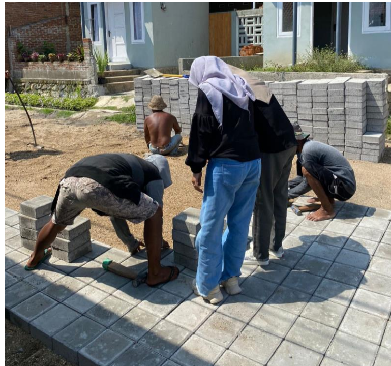
Gambar 1 percobaan pemasangan paving block
