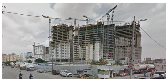
Pembangunan Wisma Atlet di 2016-2018
