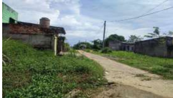
Gambar 2. Menunjukkan kondisi rumah yang rumput di sekitarnya tinggi dan tidak terawat
